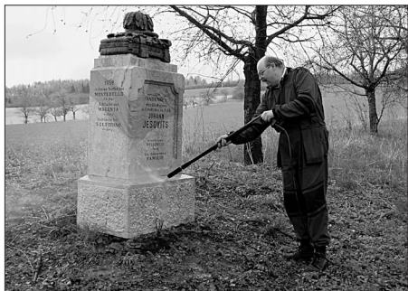
Šonov, odstraňování biomasy a exhalátů tlakovou vodou z pomníku mjr. Jesovitse
