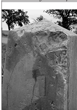
Čistěves, detail pomníku e.č. 204 v průběhu opravy
