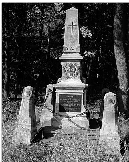
Svíb, pomník 13. praporu polních myslivců po celkové opravě
