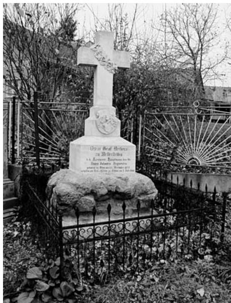
Chlum, pomník rak. setníka Oscara Beckerse e. č. 28 po celkové opravě
