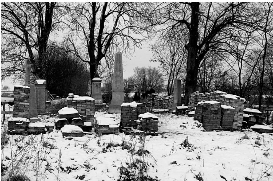
Rekonstrukce oplocení vojenského hřbitova z r. 1866 v Novém Bydžově
