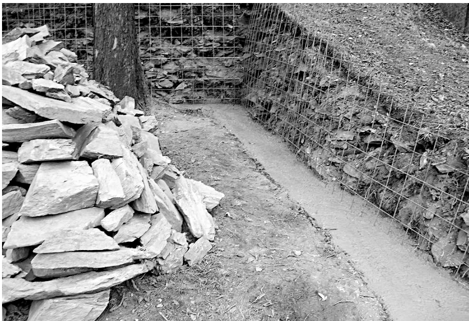
Oprava opěrní zdi Dreslerova kříže v Náchodě v r. 2006
