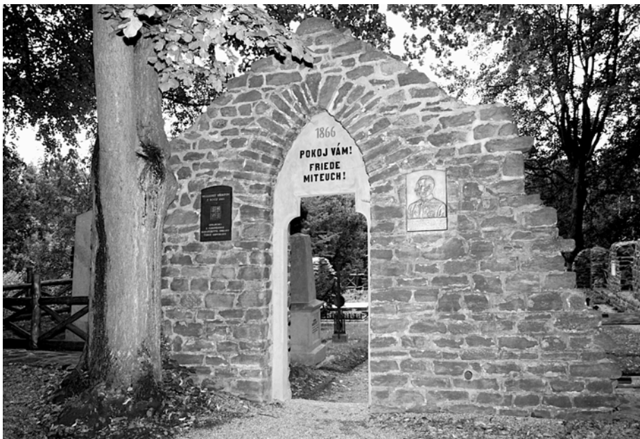
Vstupní portál vojenského hřbitova z r. 1866 v Náchodě po opravě v r. 2006
