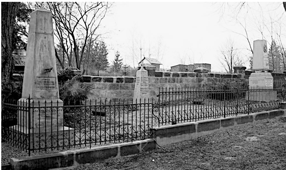
Pomníky z roku 1866 v Turnově po celkové rekonstrukci
