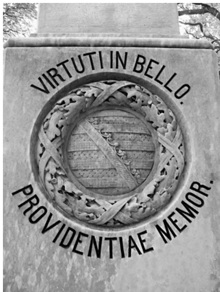
Detail centrálního saského pomníku v Probluzi po opravě
