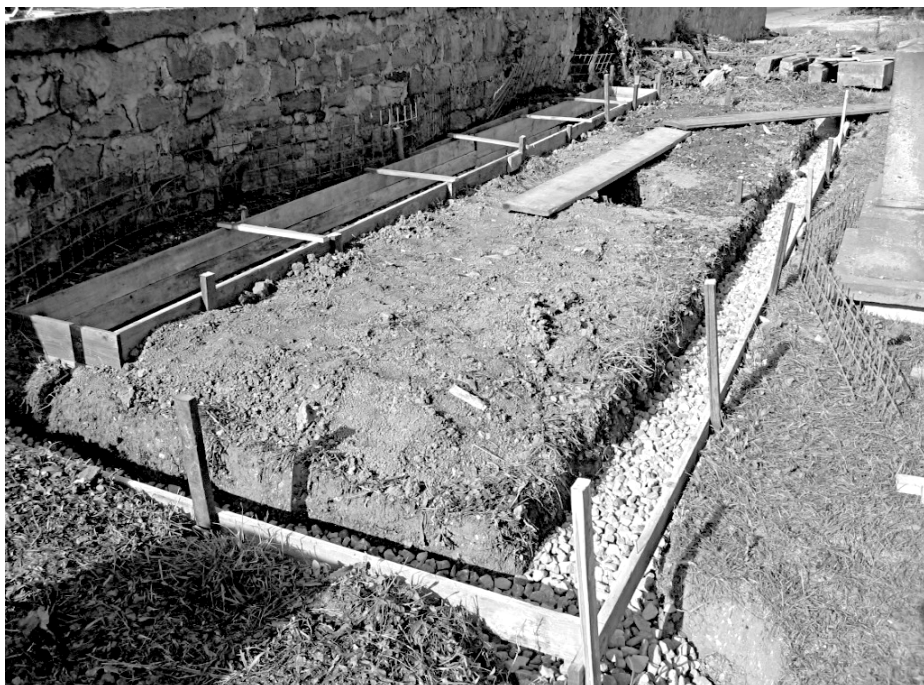
Zhotovení základové desky pro pomníky v Choustníkove Hradišti
