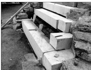
Vysokov, oprava pomníku 4. a 6. kyrysnického pluku e.č. 86
