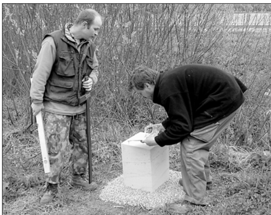
Kameníci Novotní při instalaci jednoho z křížů ve Sviňšťanech
