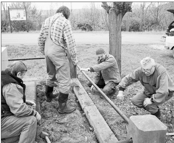
Brigáda 18. 4. 2009, Horní Lochov, rovnání pískovcového obrubníku
