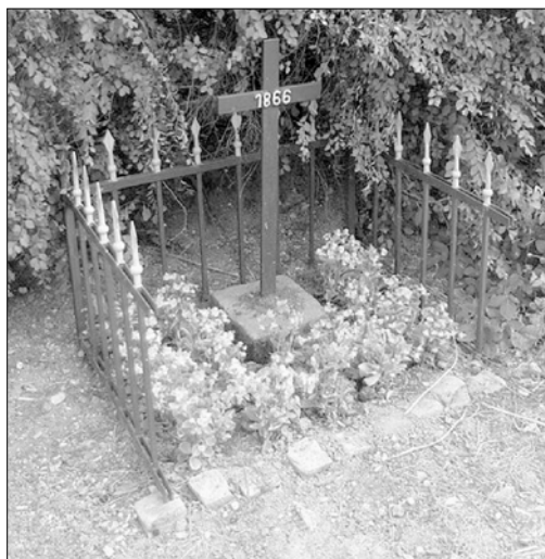
Stav památky e.č. 53 před opravou (2009)
