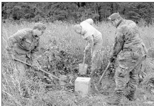
Instalace opraveného soklíku u dubenské bažantnice
