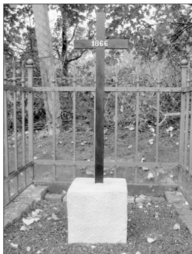
Detail kříže s opraveným soklíkem
