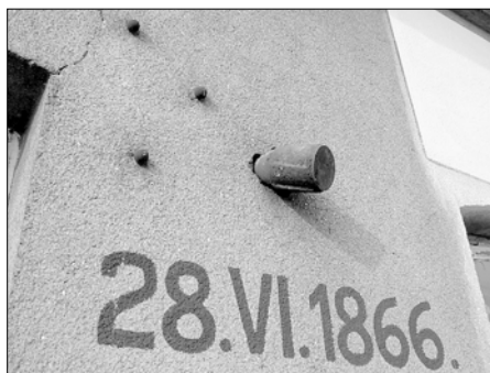
Detail rakouského šrapnelu a kartáčových kulí ve stěně fasády skalického nádraží před jeho rekonstrukcí (2010)
