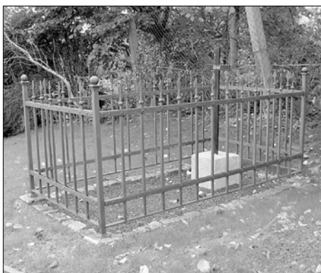
Současný stav památky po opravě (podzim 2011)
