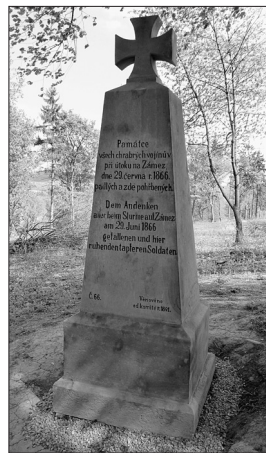
Zámezí ev. č. 16, stav po opravě 1. 5. 2012
