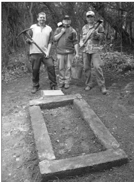
Betonování základu pomníku ev. č. 43 14. 9. 2013 (foto J. Náhlavský)
