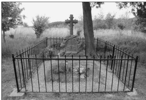
Pomník ev. č. 65 u Horního Přímu po opravě
