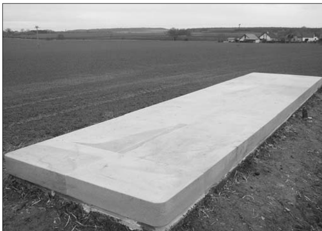
Základová deska pomníku jízdy u Střezetec obložená pískovcem
