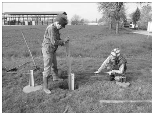
M. Suchý a V. Hladíková při betonáži základu tabule naučné stezky, 12. 4. 2014
