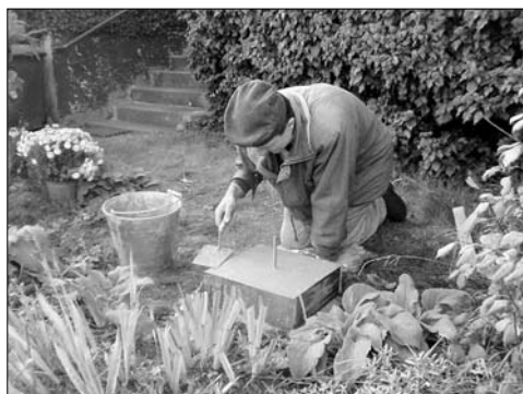
J. Náhlavský při betonáži základu pomníku ev. č. 25 (1. 11. 2014)
