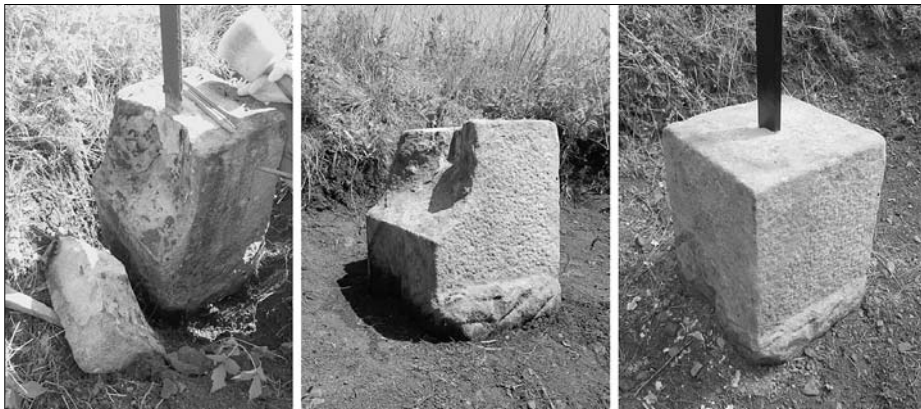
Typový kříž ev. č. 8 v průběhu oprav (foto T. Vondryska)
