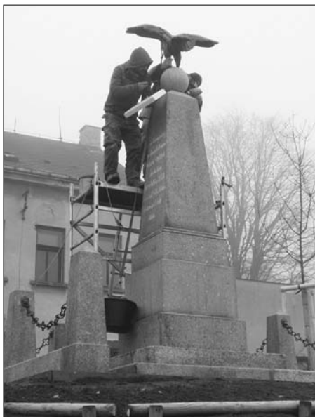
Ukotvení koule s orlicí na pomník ev. č. 19 v Jablonci n. N., 25. 11. 2017 (foto J. Náhlovský)
