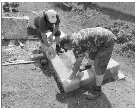
Spárování obrubníkových kamenů u téhož pomníku (foto J. Náhlavský)
