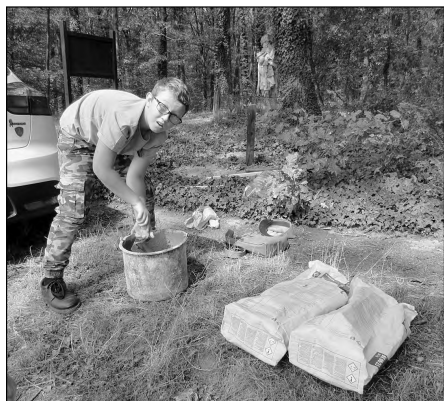
Betonování traverzy pro kříž u Myslivce 15. 8. 2018 (foto J. Vilím)
