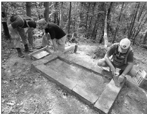
Betonáž základu pomníku ev. č. 47 dne 20. 7. 2019 (foto D. Koral)
