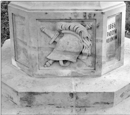
Josefov, pomník rakouského pěšího pluku č. 21 – očištění pomníku bylo provedeno nevhodným prostředkem, který nepřírozně vybělil kámen a zcela odstranil zbytky původní barevné polychromie vojenských trofejí (foto T. Vondryška)
