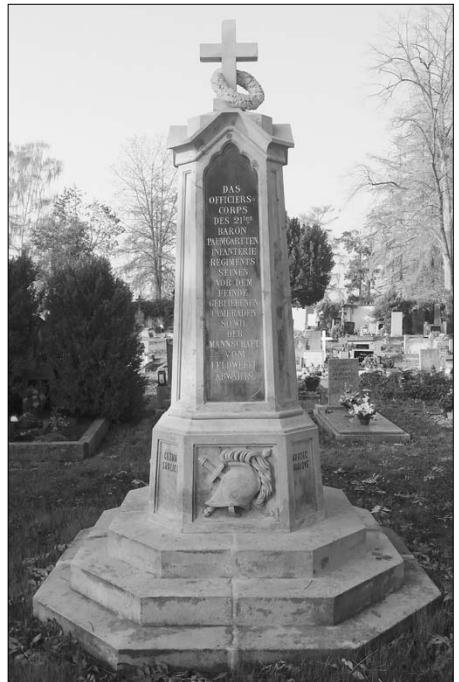
Josefov, pomník rakouského pěšího pluku č. 21 – očištění pomníku bylo provedeno nevhodným prostředkem, který nepřírozně vybělil kámen a zcela odstranil zbytky původní barevné polychromie vojenských trofejí (foto T. Vondryška)
