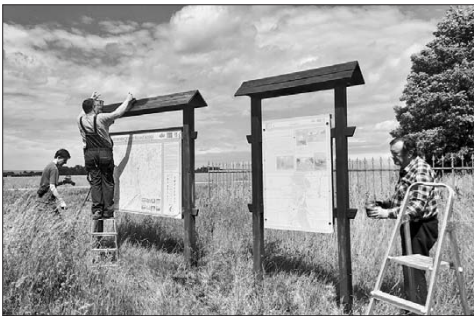
Nátěr stojanů NS Tovačov 6. 6. 2020 (foto J. Juna)
