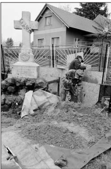
Chlum, betonování základu plotu za pomníkem setníka Beckerse, duben 2020 (foto R. Balcárek)
