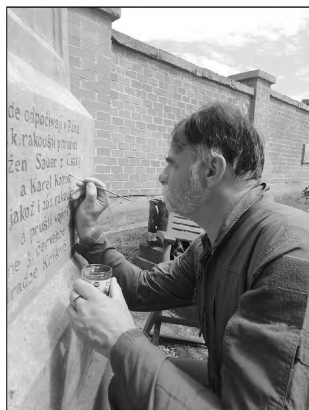
M. Suchý obnovuje písmo na pomníku v Cerekevici nad Bystřicí (foto R. Balcárek, 31. 5. 2021)
