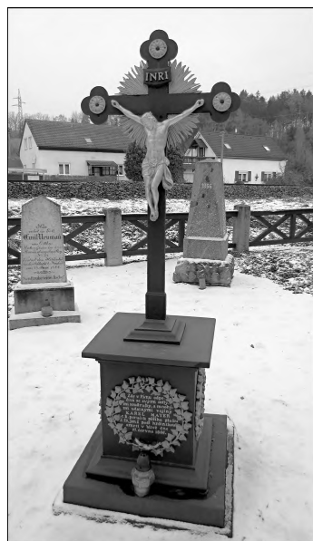
Kříž ev. č. 49 ve Vysokově po renovaci (foto M. Holas, leden 2022)
