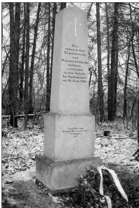
Opravený pomník ev. č. 84 u Stříteže (foto V. Grof)
